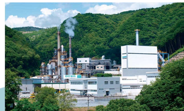
エコシステム山陽。廃棄物処理炉の投入口の大きさを活かし 車載用リチウムイオンバッテリー焼却工程にも活用
