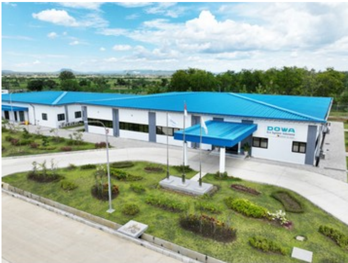
DESI のオフィス棟。敷地内にあるトレーニングセンターでは学生や政府機関向けにセミナーなども開催する( 同社提供)
