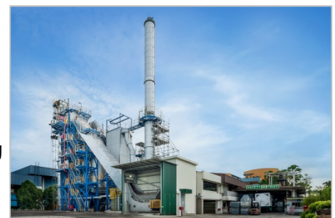
TEC 社 新焼却炉 外観
